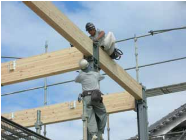
図5 MKシステムの施工状況
