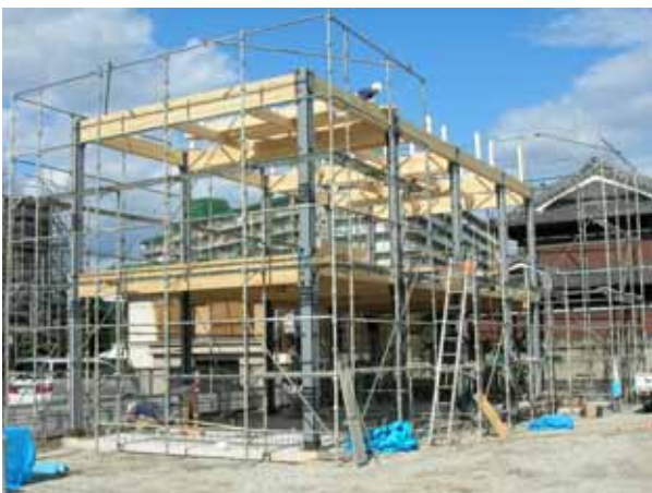
図1 WSハイブリッド工法
