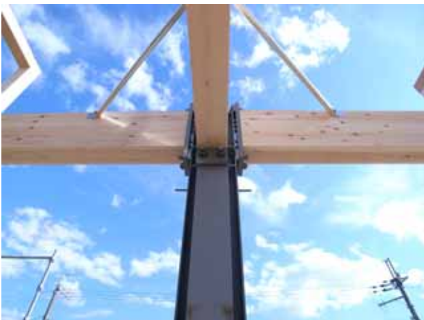
図1 新耐震工法WS造接合部
