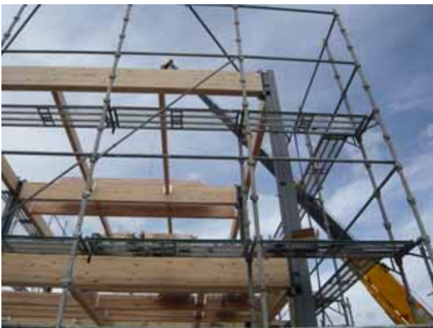
図5 MK システムの工事状況
