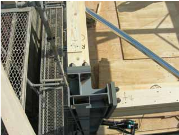
図4 HCT デザイン構成柱の工事状況
